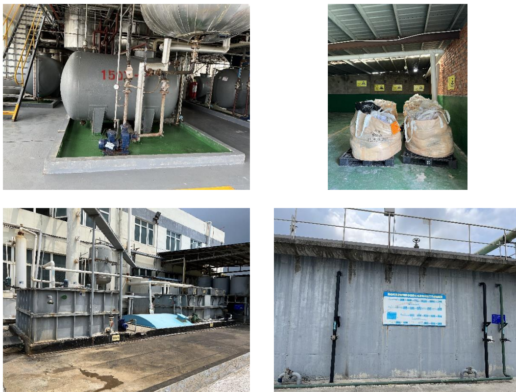
图 5.2-2 生产车间及三废处理区现场照片
